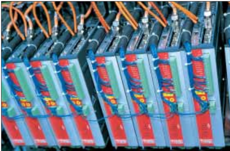
1 In der Holzbearbeitungsanlage werden 31 Linearmotoren von Beckhoff-Servoverstärkern AX2000 über vier Lightbus-Ringe angesteuert
