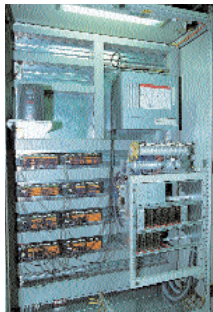
Bild 5. Senkt Lagerkosten: Schaltschrank-PC mit Pentium-III-850-Prozessor; er ersetzt eine aufwändige Groß-SPS-Lösung mit drei PC-Einsteckkarten
